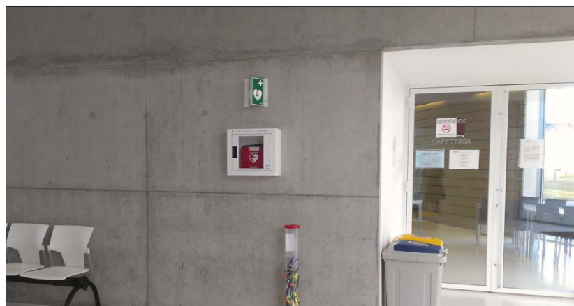
Facultad de Ciencias de la Salud. Edificio I: Philips HS1
