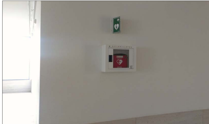
Edificio Rectorado: Philips HS1
